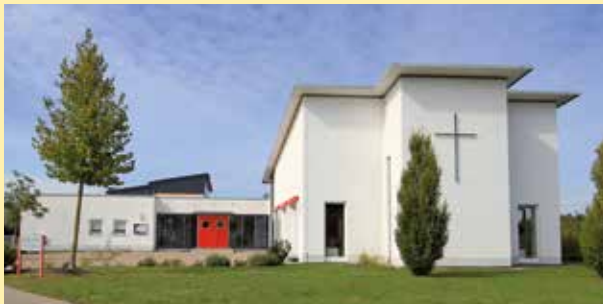
Gemeindezentrum Philipp-Melanchthon-Haus Jettingen-Scheppach
