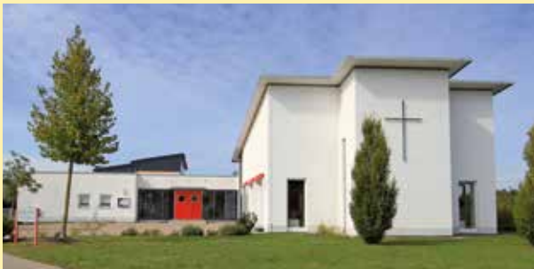
Gemeindezentrum Philipp-Melanchthon-Haus Jettingen-Scheppach
